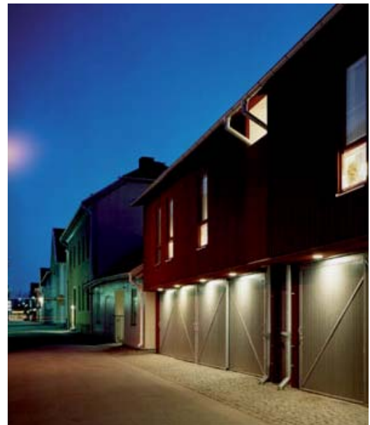
Bild 26 Kvarteret Balder, Lidköping Malmström Edström Arkitektkontor
