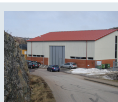
På ömse sidor om vägen i Dalen finns industribyggnader och uppställningsytor. Bergskanterna i området är sprängda. Området upplevs som skyddat.
