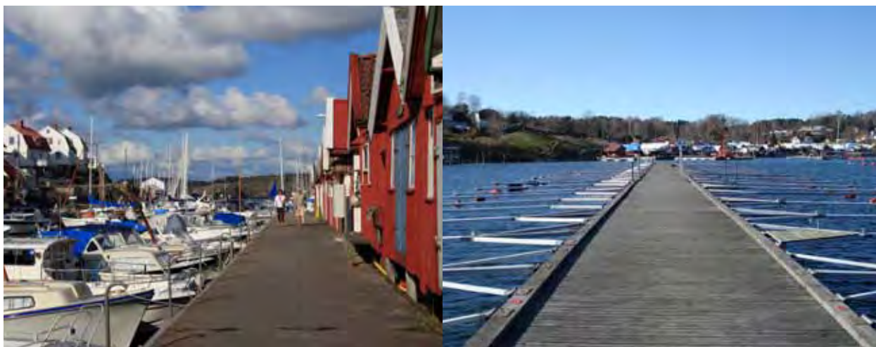
Åstol t v. / Brygga småbåtshamn Almösund, foto: Radar Arkitektur & Planering t h.
