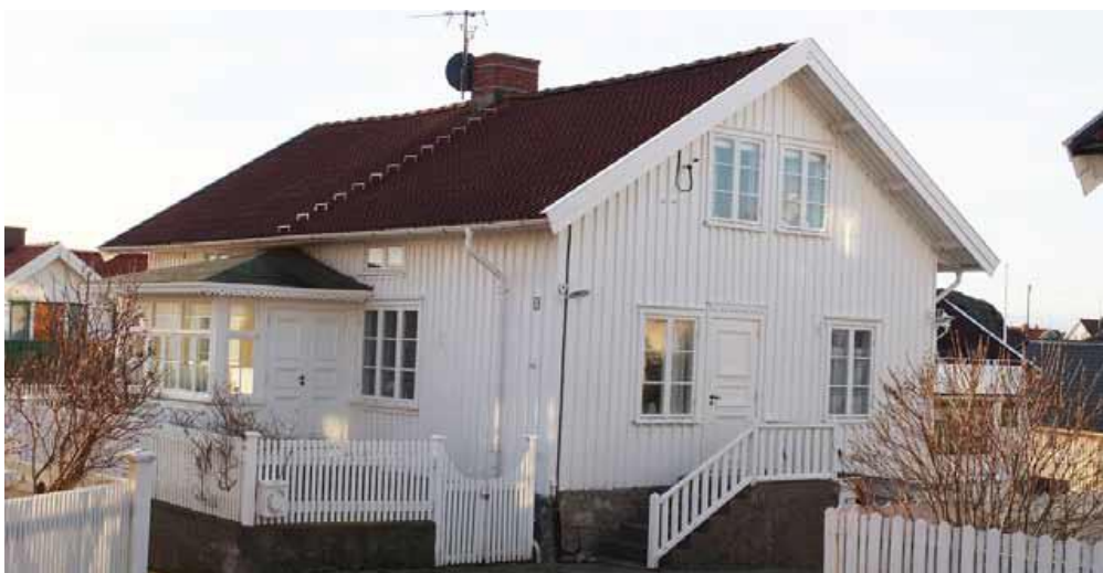
Figur 13. Äldre dubbelhus från 1890. Källa: Kulturmiljöunderlag Koholmen
