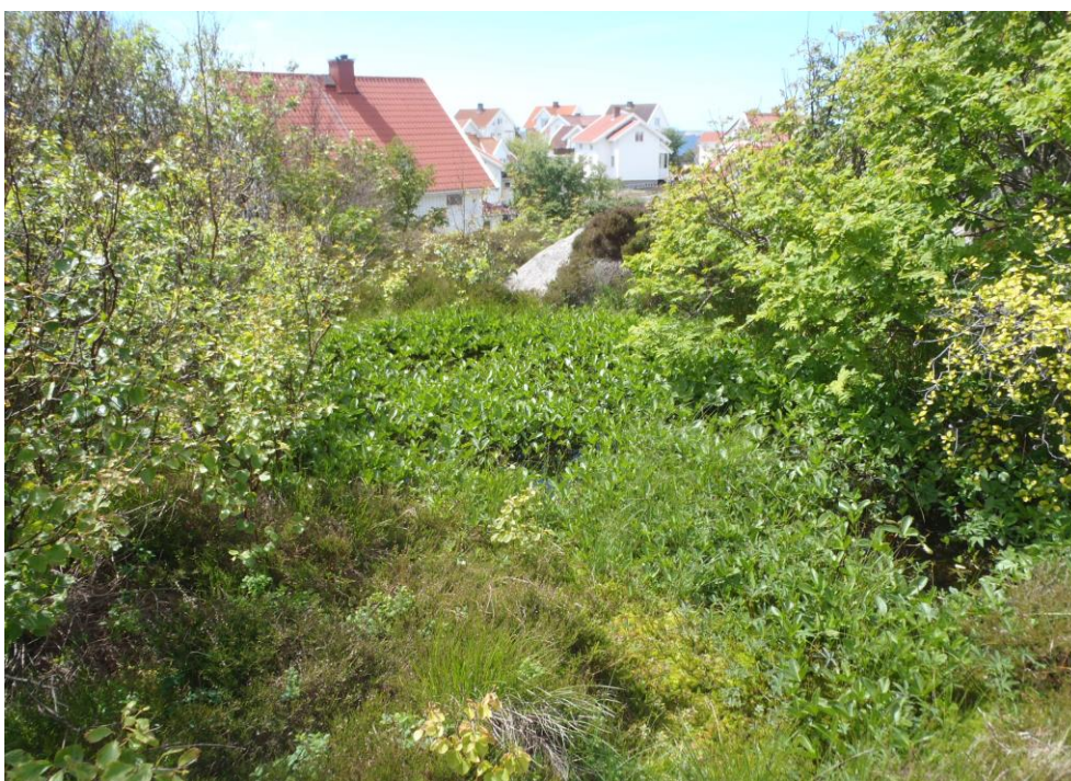
Damm A.2. Dammen är helt övervuxen av främst vattenklöver.
