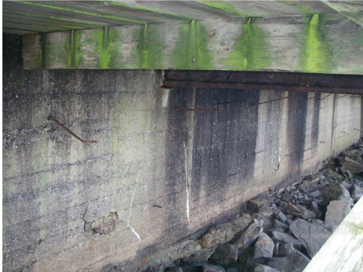
8. Betongkaj, delområde C
