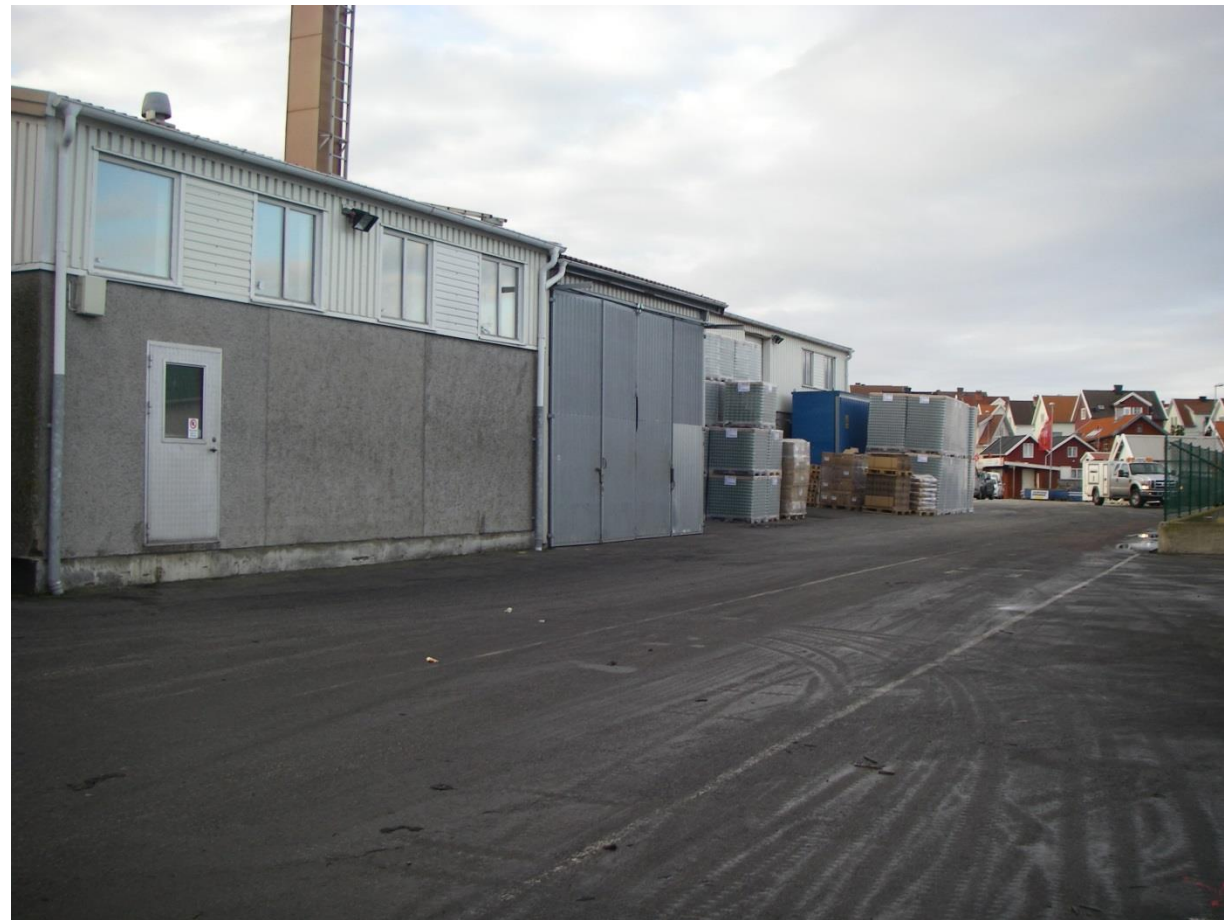
10. Fabriksbyggnad och asfaltplan
